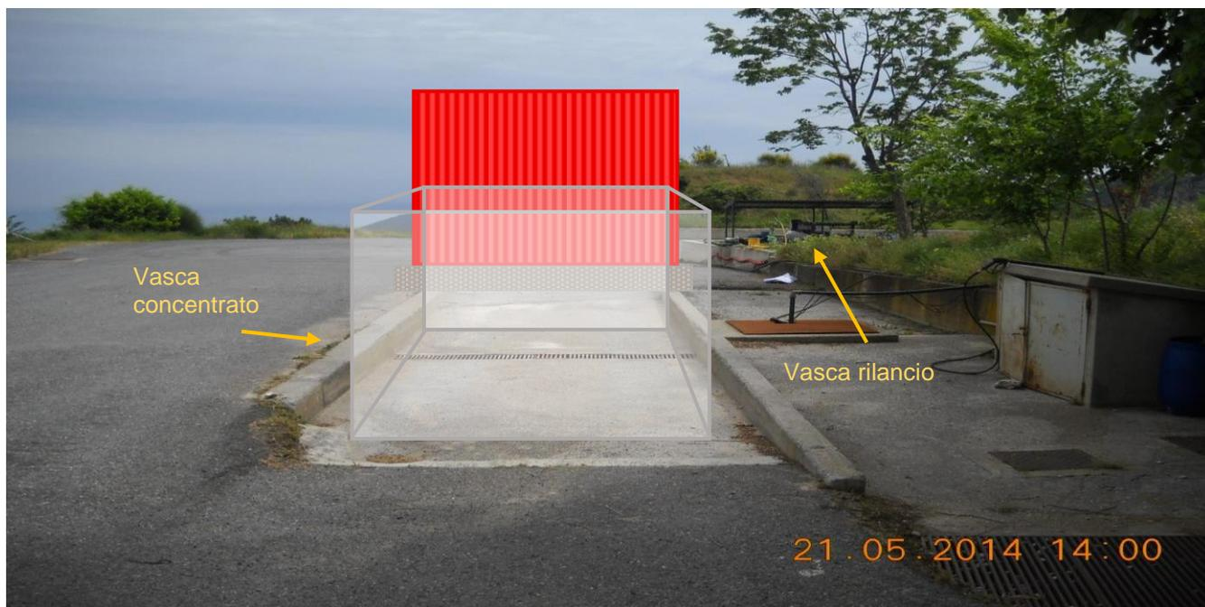
Fotoinserimento 1 – Discarica Casei in Magliolo, container per impianto ad osmosi inversa con adiacente vasca esistente di rilancio del percolato e vasca di stoccaggio concentrato – 418 m s.l.m
