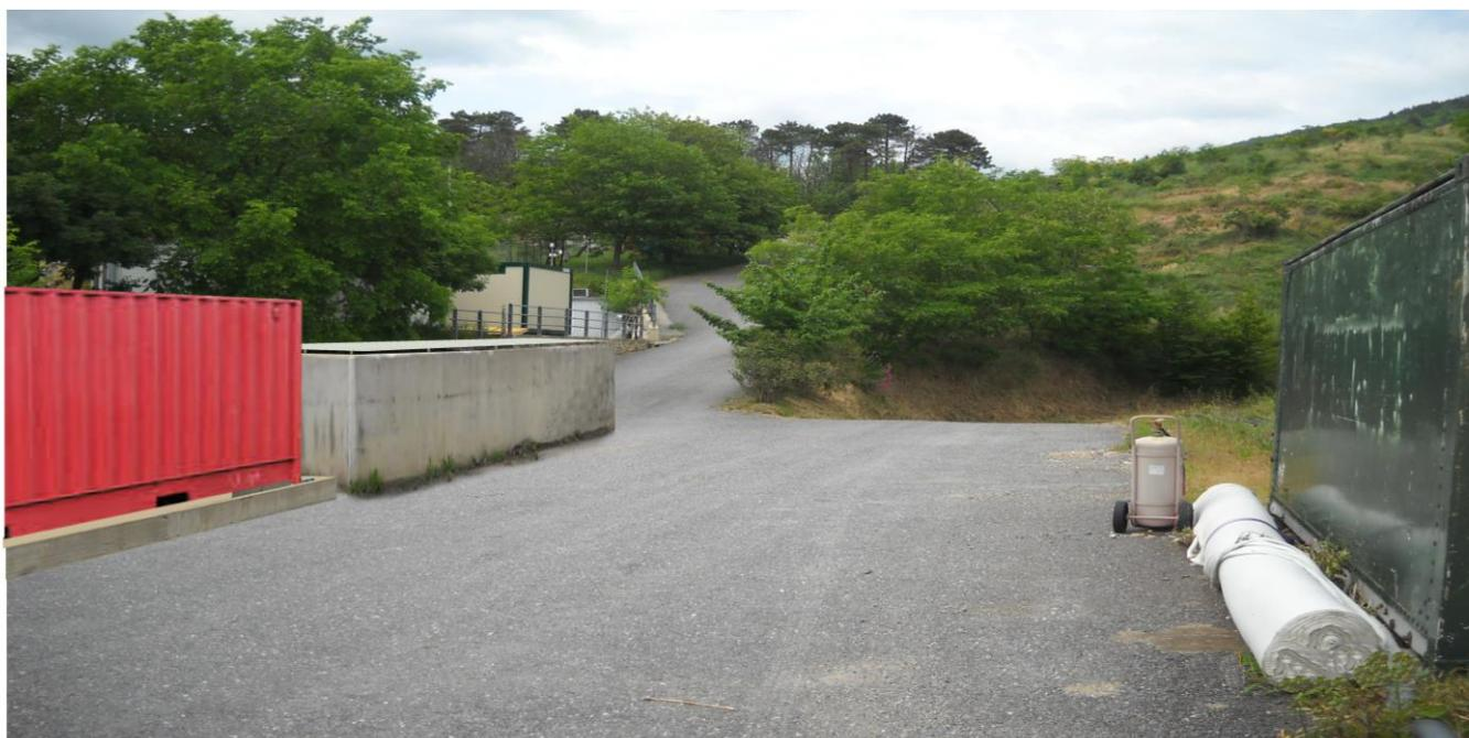
Fotoinserimento 2 – Discarica Casei in Magliolo, container per impianto ad osmosi inversa (lotto 1A) ed adiacente vasca di stoccaggio del concentrato (lotto 1B). - quota 418 m s.l.m
